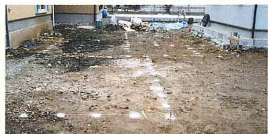
■ 施工前のパイプの位置決め
